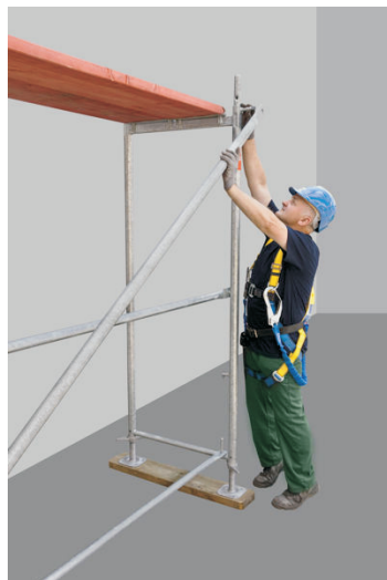
Rys. nr 4. Montaż pierwszego stężenia.
